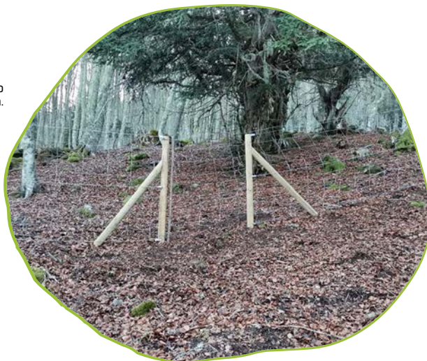
Reparación do cerramento cinxético para o peche de exclusión.
