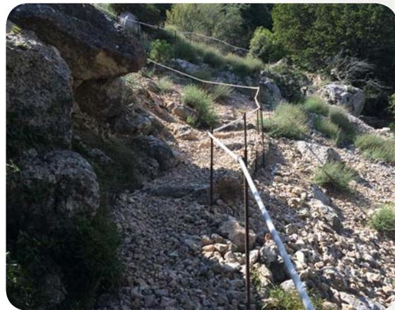
Acondicionamiento de sendero con una malla baja (altura de 30 cm) de acero galvanizado de triple torsión, que pasa por la parte inferior del firme rocoso y anclada con hilo de acero galvanizado en las barras de la barandilla aguas arriba. En la imagen de la izquierda se observa el trasporte de material para cercados de exclusión mediante mulas. Tejeda de Cosp (Serra de Cardó). Fotos: Jordi Bas y Jordi Camprodon.
